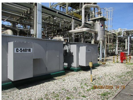
ภาพที่ 2.1-26 การติดตั้งผนังกันเสียง
