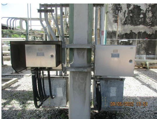
ภาพที่ 2.1-37 ตู้ Panel แบบป้องกันการเกิดประกายไฟ
